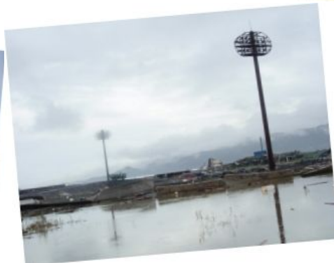
破壊され、水に浸かったままの野球場
