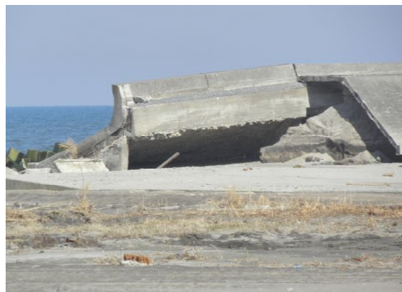
【防波堤も地震・津波の影響を受けている】
