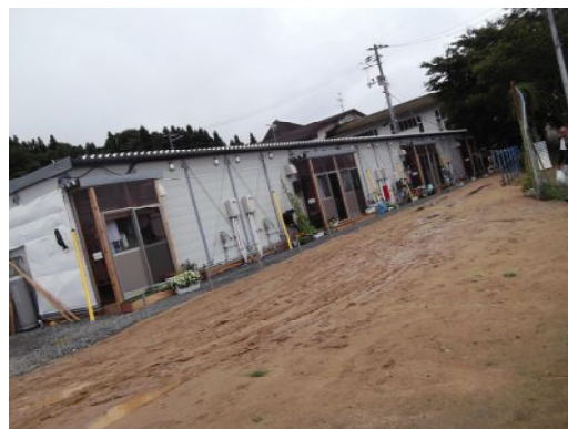
グラウンドに設置された80世帯の仮設住宅
