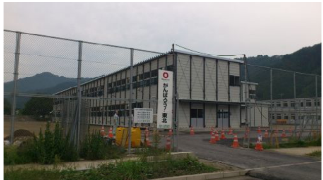
(仮設校舎の様子)
