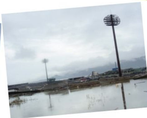
破壊され、水に浸かったままの野球場
